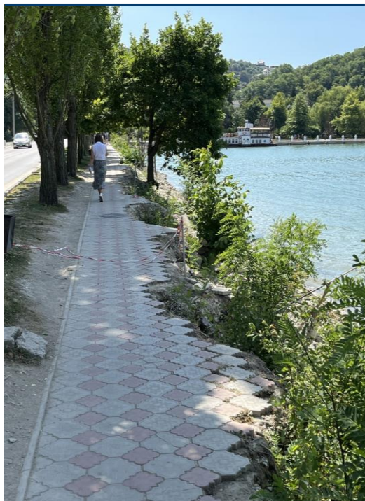
Текущее состояние набережной Этап I (СМР начаты 09.22)
